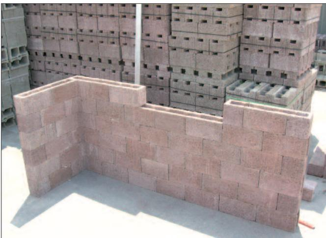
Holzspan-Mantelsteine gemäß ÖNORM EN 15498 sind Schalungssteine aus Holzspanbeton, die aus Längswandungen bestehen, die mit Querstegen verbunden sind. Gegebenenfalls ist ein Zusatz-Dämmstoff (EPS, Kork, udgl.) integriert. Sonderformen von Holzspan-Mantelsteinen dienen für die fachgerechte Ausführung von Konstruktionsdetails, wie Ecken, Gewände, Deckenroste, usw.
